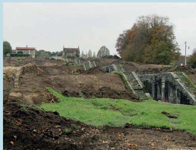
Remodelage des paliers
